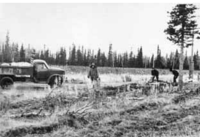
Рис. 7. Ремонт дороги из пос. Умбозеро в пос. Титан. Октябрь 1957 г.
