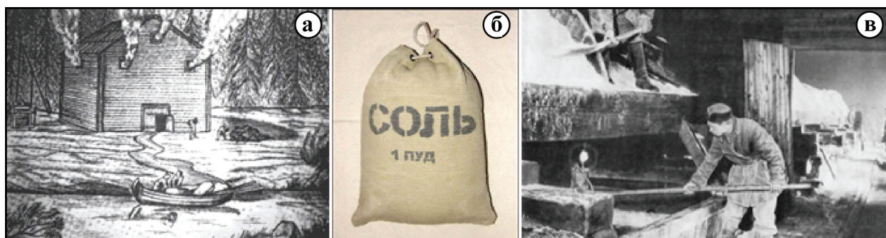
Рис. 7. а – Получение соли – слеварня; б – стоимость пуда соли 1 рубль 2 алтына и 1 м 3 дров; в – процесс варки соли на цренах
